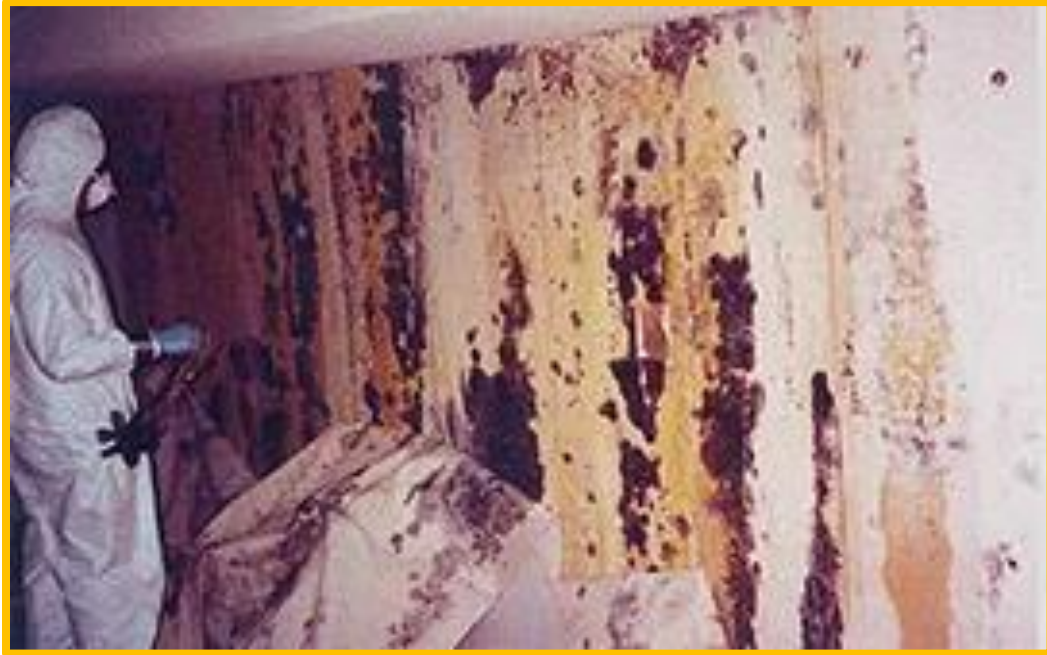
รูปแสดงผนังห้องที่มีเชื้อราเจริญเติบโตเป็นจำนวนมาก
